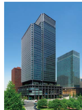
新丸ビル外観
