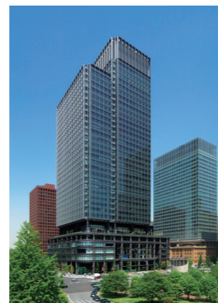
新丸ビル外観
