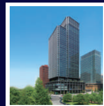
JR 東京駅丸の内北口を出てすぐ。 新丸の内ビルディング (オフィス棟) 110F
