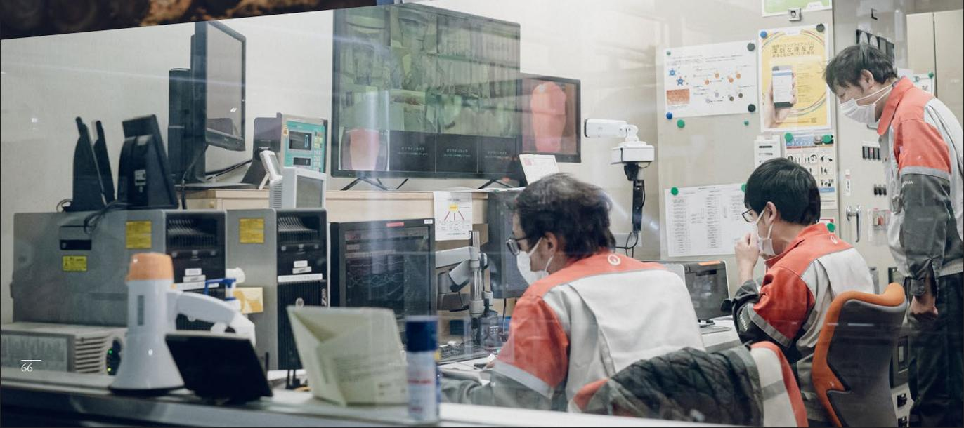
2015年5月に設立され、青森県初の木質バイオマス発電所(平川発電所)を運営する「株式会社津軽バイオマスエナジー」。津軽地方の間伐材やりんごの栽培過程で発生する剪定枝・老木などから自社工場内で作る木質チップを燃料に発電。1日210～240tの燃料チップをつくり、年間では7.2～7.4万tの間伐材を利用。発電した電力は、主要株主である株式会社タケエイが100%出資して設立した小売電気事業者「株式会社タケエイでんき(本社:東京都港区)」を通じて市内の公共施設等に供給されており、エネルギーの地産地消に貢献しています。発電出力は、毎時約6,550kwで、稼働日数は330日。年間おおよそ1万4,000世帯分の電力を供給しています。
