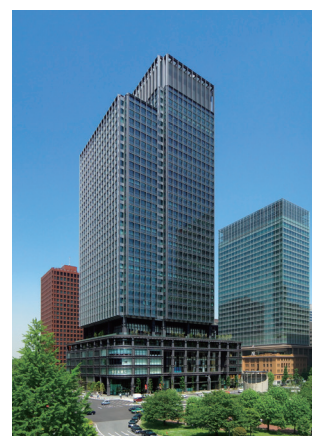
新丸ビル外観
